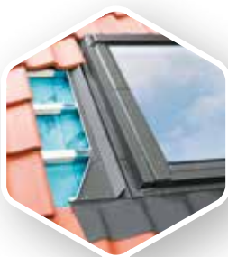
EHV-AT Thermo umożliwia docieplenie okien dachowych ponad powierzchnią łat.
